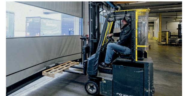
Durch die Windlastklasse 3 nach DIN EN 12424 ist das Tor als Innen- und Außentor geeignet.
